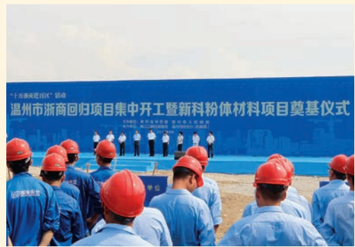
8月15日，温州市浙商回归项目集中开工暨新科粉体材料项目奠基仪式举行。
