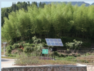
太阳能污水处理池
