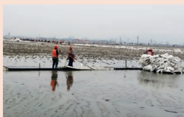
江南海涂围垦吹填及软基处理二期工程施工现场
