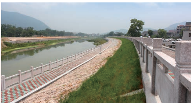
鹿城区戍浦江大潭段河道生态建设工程治理后
