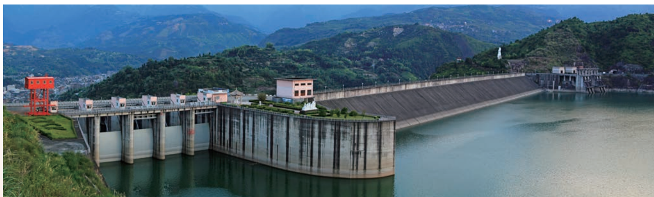
集原水供给、防洪、农业灌溉、发电为一体的珊溪水利枢纽
