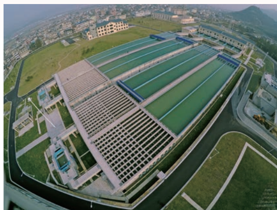
市自来水分公司西向水厂全景
