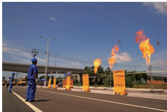
市燃气公司员工在现场进行中压管网天然气置换
