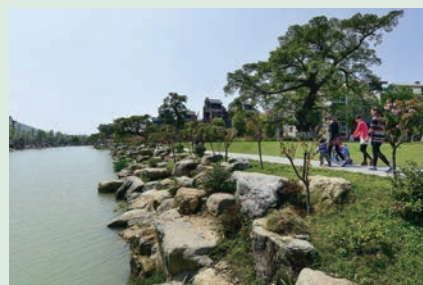
河道治理后的塘下镇陈岙村被评为“浙江最美乡村”
