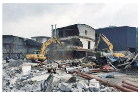
10月22日，永嘉县瓯北街道推进“大拆大整”专项行动
