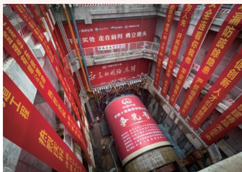
5月5日，中铁十局集团温州瓯江引水工程涉铁段开工仪式在瓯海区泽雅镇周岙村举行，图为大型盾构机在始发井作业 (赵用/摄)
