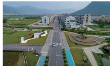
瑞安市曹村镇县道线马线
