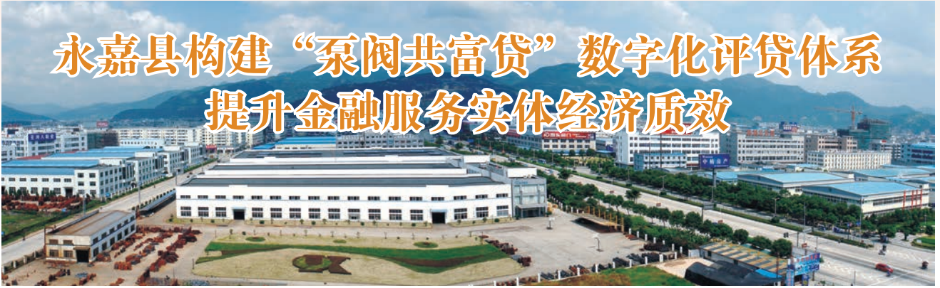
永嘉县工业园区
