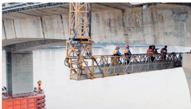
工作人员检修桥梁
